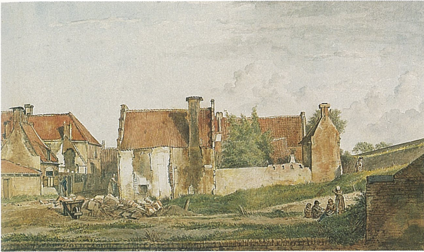
De stad is rond 1800 overal in verval. Huizen storten in en worden gesloopt. Hier aan de Raamgracht zijn enkele huizen weggebroken.
