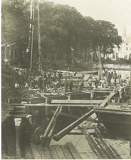
Arbeiders aan het werk in een bouwput bij de Melkbrug over het Spaarne rond 1890. De werkdagen van arbeiders zijn lang (gemiddeld 12 uur) en de omstandigheden vaak slecht.
