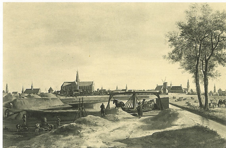
Het werk aan de stadsuitbreiding is eindelijk begonnen. Met paarden- en mensenkracht worden vestinggrachten gegraven en wallen opgeworpen (1671).
